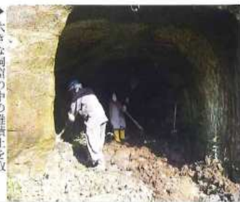
▶大きな洞窟の中の埋積土を取り除き石を敷く。
