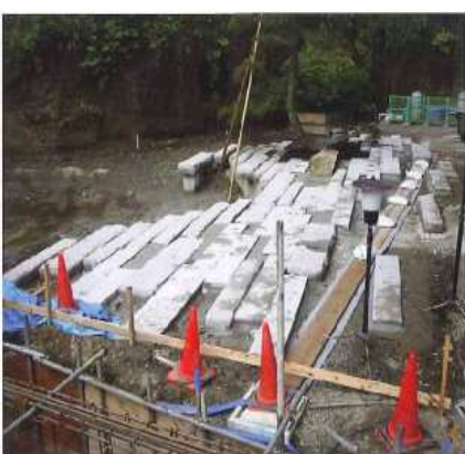
▶石を敷き込む。平らな面。割肌の面タマリエウを削るも部分を組み合わせている。
