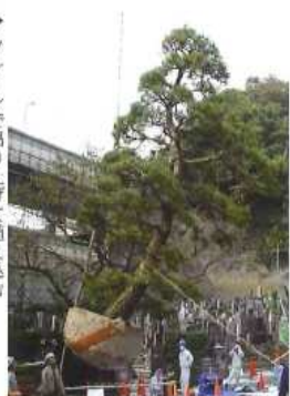
▶クレーンで吊り上げて植え込む
