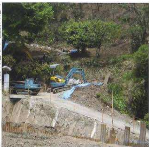
▶山にも重機が入り、開墾を完成する
